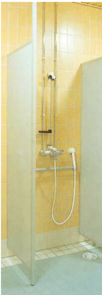
Dusjvegg av 10 eller 13 mm høytrykk-laminat. Fastmontering mot tak.
